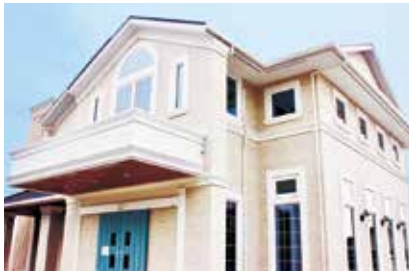
▲建設中の「アイ内科クリニック」。最近では、病院や介護施設からの建設依頼も急増中!
